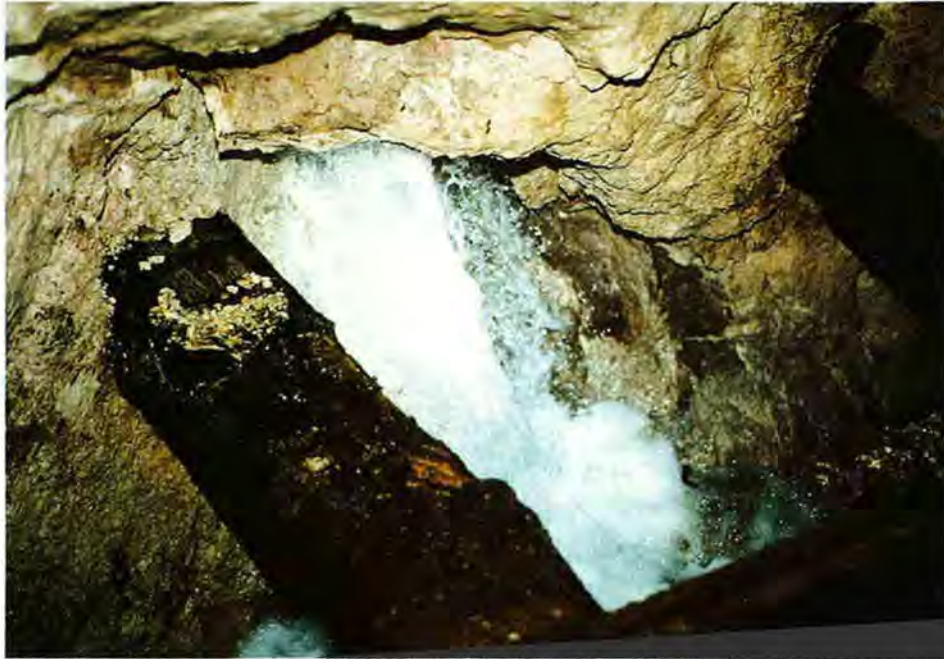
Fig. 5: Stollenaustritt Nr. 37, Zuchenfluß, stark gestörter Wettersteindolomit, Stationierung 1828 m (Foto: P. RAMSPACHER).
